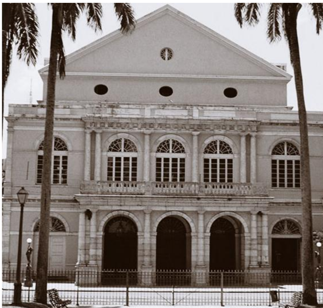
Fachada principal do Teatro de Santa Isabel.
