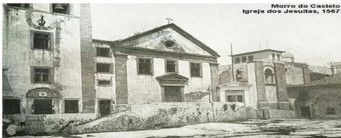
Igreja dos Jesuítas. A construção é do século XVI
